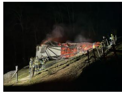
Le chalet a été entièrement détruit par les flammes. Photo Le DL/R.B.
